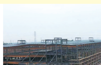
(宁波华楷项目现场施工进度照片)
